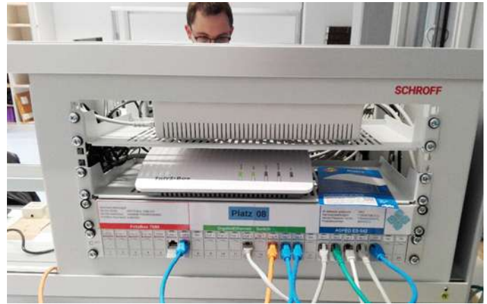
^ Schüler arbeiten an der neuen Telefonanlage
