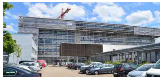
64 | Sanierung und Modernisierung: Architektenbericht
