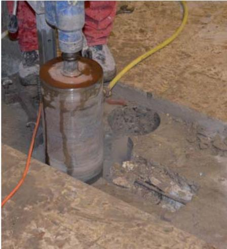
Fundamente zur Versteifung und Herstellung der Erdbbensicherheit
